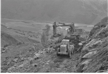
Vegarbeid med Ørsdalsvegen øverst i Eikbrekka.
